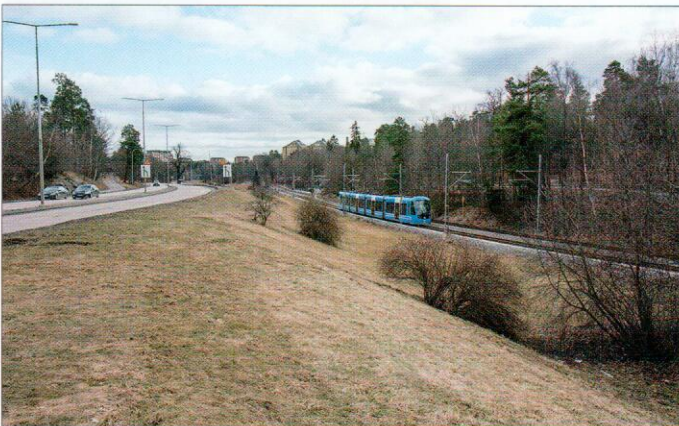
På sträckan mellan hållplatserna Baggeby och Bodal ska den nya bansträckningen ansluta till den befintliga banan.
